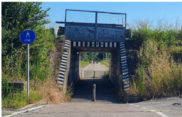
Foto sottopasso ciclopedonale SP18
