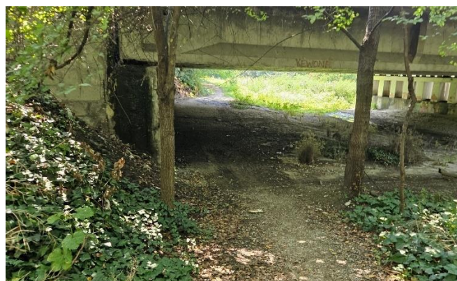
Foto del sottopasso in destra idraulica
