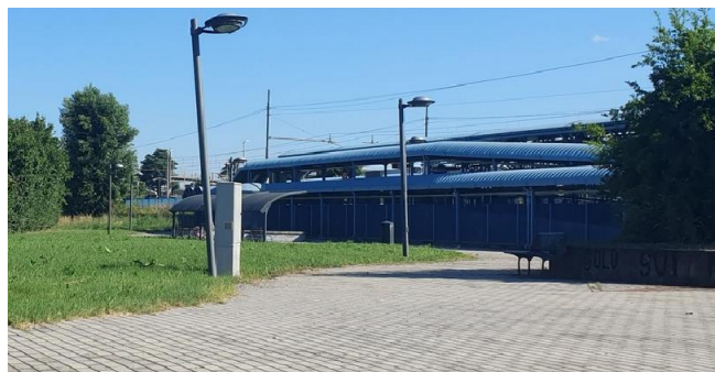
Foto accesso alla stazione di Calderara-Bargellino
