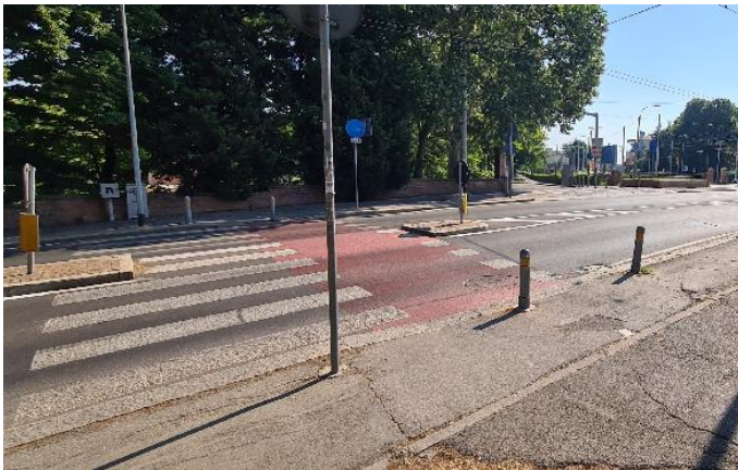
Foto attraversamento via della Barca
