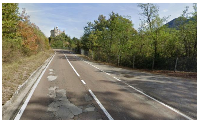
Itinerario lungo la SP62 (vista direzione nord)
