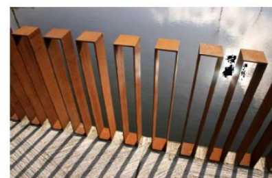
Parapetto in Corten
