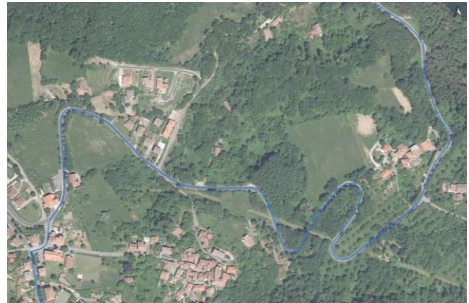
Itinerario in ingresso in località Badi
