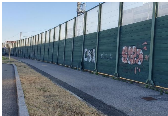
Ciclopedonale in corrispondenza del parcheggio di via Bertoldo
