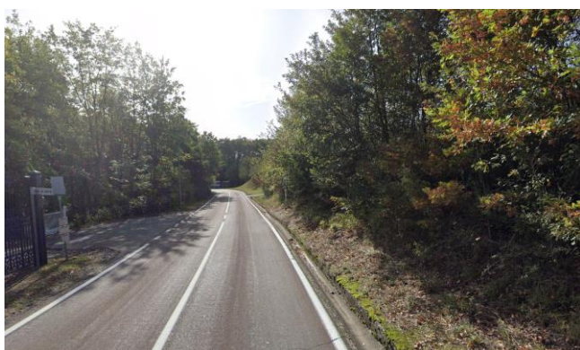
Lungo la SP62. Inizio tratto con corsie monodirezionali
