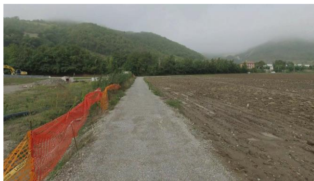
Percorso nei pressi dell'immissione su via Sperticano
