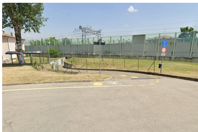
Ciclabile esistente in uscita dal sottopasso ferroviario
