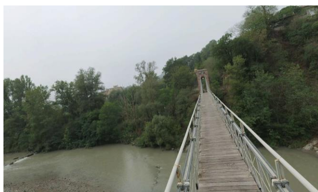
Ponte delle Streghe
