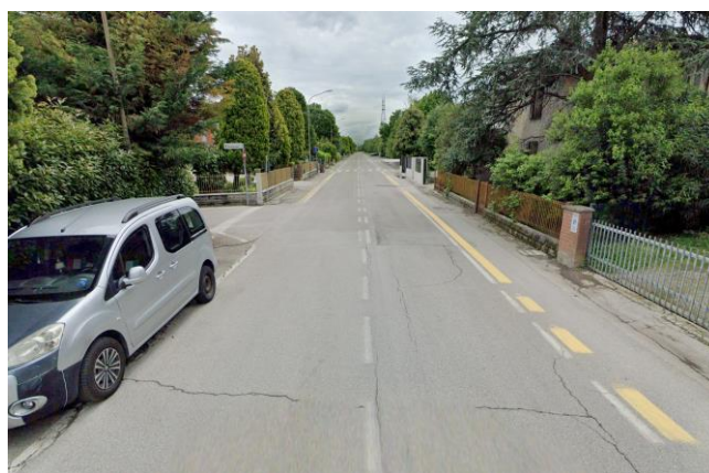
Ciclabile monodirezionale esistente (direzione sud) lungo via Guisa, in prossimità dell'incrocio con via Francesconi
