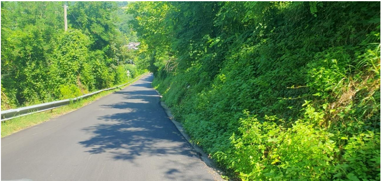
Foto tratto evidenziato - lungo via Lama di Reno (progressiva da + 1.400 m a +1.600 m)
