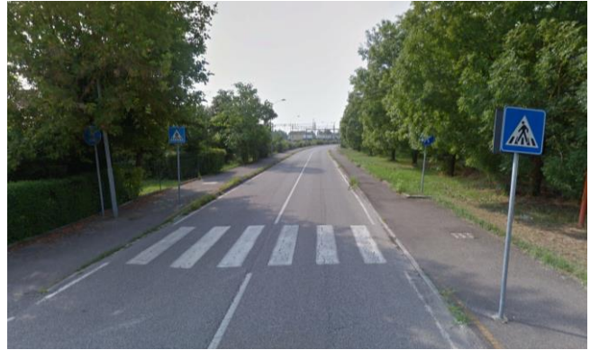
Attraversamento di via Guisa da ovest ad est della carreggiata
