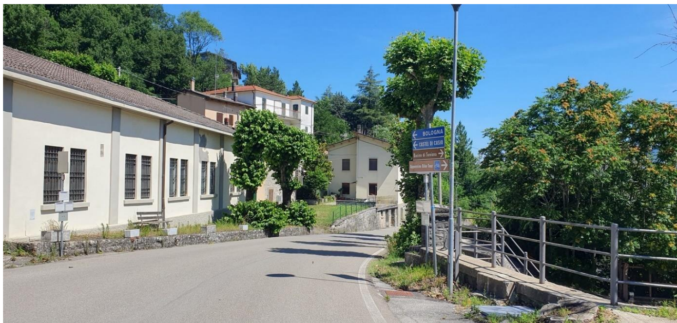
Foto del tratto con pendenza (SP23) vista verso nord
