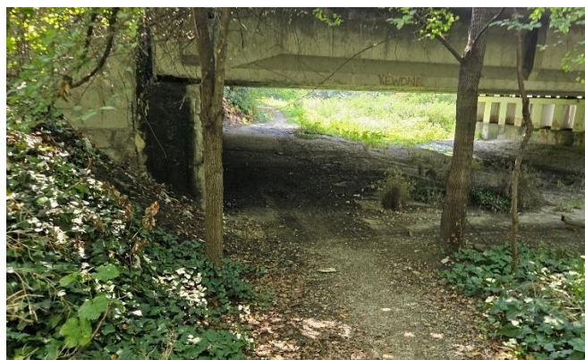
Foto del sottopasso in destra idraulica
