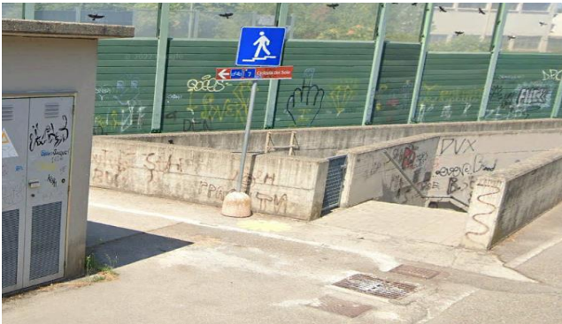
Scalinata in corrispondenza di via Cento
