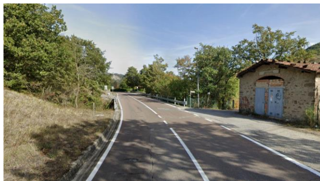
Ponte della SP62 in prossimità di Località Ginepri/Molino Rizzoni
