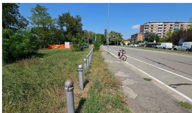
Foto dell'area verde in cui realizzare il percorso monodirezionale VR-FI in destra idraulica
