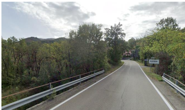
Itinerario lungo la SP23, ingresso località Suviana
