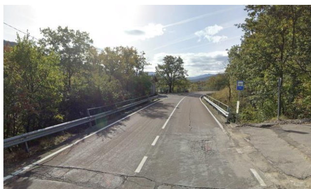
Lungo la SP62. Fine tratto con corsie monodirezionali
